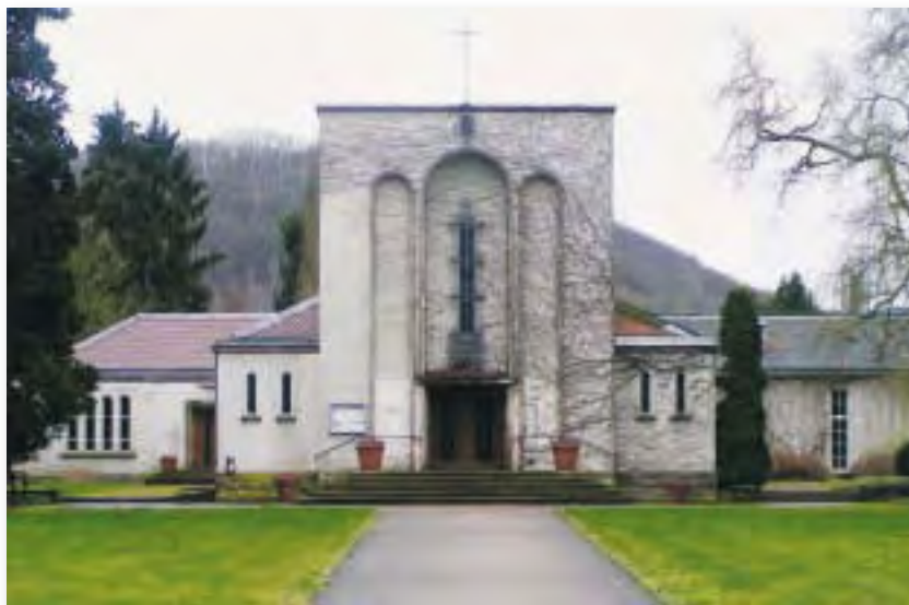
Die 1928–30 nach Plänen von Walther Kruspe errichtete Einsegnungshalle rezipiert Formen des monumentalen Kirchenbaus der Zwischenkriegszeit, Foto: Jeanette Dillinger (2007)
