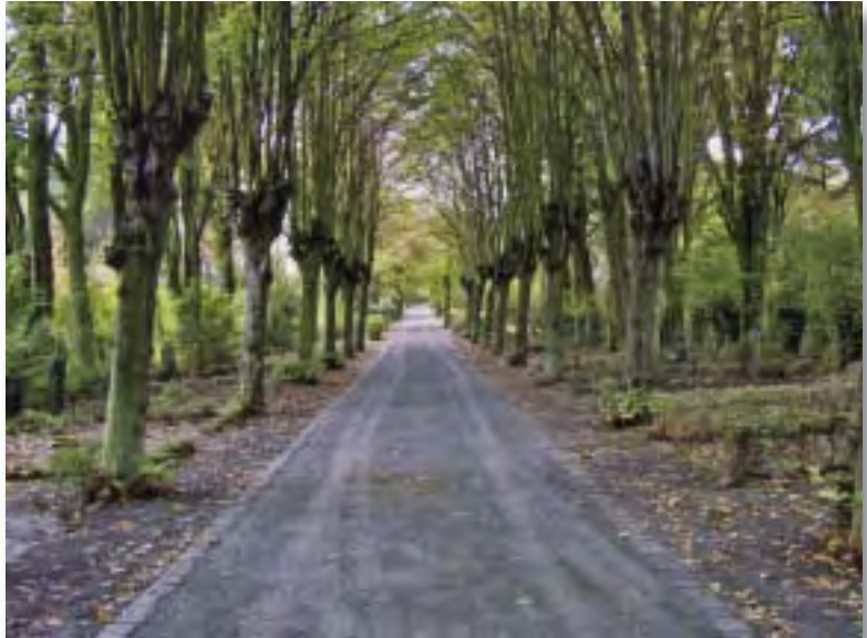
Instand gesetzter Längsweg Friedhof II, Blick nach Norden, Foto: Luise Schier, LDA
