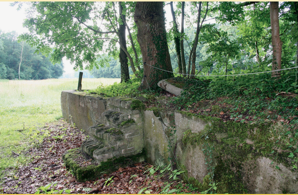
Anfang 1920 begannen sieben Meißendorfer Familien den Bau eines privaten Wasserkraftwerks zur eigenen Stromerzeugung. Zu diesem Zweck wurde die Meißer gestaut, um die Kraft des Wassers zu nutzen. Am 13. Februar 1923 konnte die Turbine in Betrieb genommen werden – sieben Jahre bevor Meißendorf (Landkreis Celle, Niedersachsen) an das öffentliche Stromnetz angeschlossen wurde. Die Aufbauten sind heutzutage nicht mehr zu sehen. Lediglich der Betonsockel zeugt von dieser interessanten Pionierleistung.
