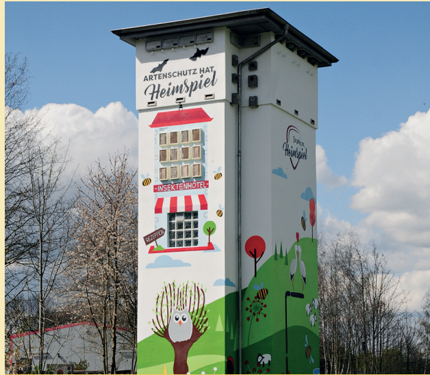
Der Trafoturm in Schaephuysen (NRW, Rheinland) wurde 1912 errichtet. Ab 2009 wurde der Turm mit Unterstützung der lokalen Initiative „Heimspiel“ als industriehistorische Landmarke im Sinne des Artenschutzes genutzt, gleichzeitig dient er seit 2023 als Zeitfenster, mit einem Blick in die 1950er Jahre.
