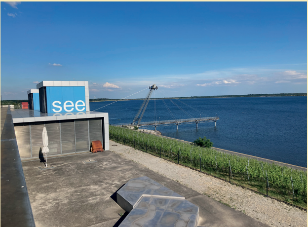
Ein Teil des letzten Abraumbasissetzers (Baujahr 1973) vom Tagebau Meuro in der Lausitz dient heute als Seebrücke am Großbräschener See, ein Tagebausee in Brandenburg. 1994 entstand dazu die Idee, 2004 wurde der Bandabsetzer demontiert. Der 66 m lange Abwurfslieger mit Mast und Seilabspannungen ist nun ein Wahrzeichen für den Braunkohlenabbau und für den Neuanfang als Seestadt.
